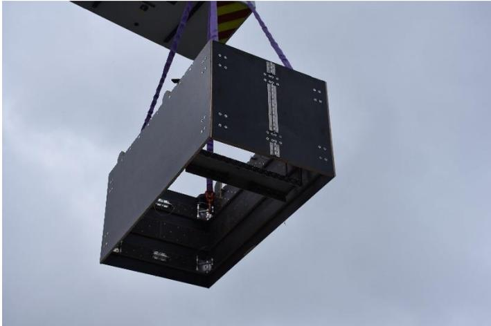
Das HSRS kann mittels Kran oder Drehleiter gehoben und versetzt werden. Das mitgelieferte Gehänge kann sowohl an den Querstreben der Klappscharniere als auch an den Querstreben der Eckprofile eingesetzt werden.
